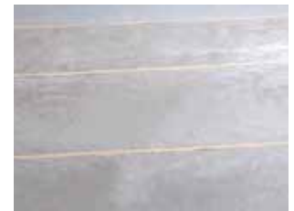
Folien müssen überlappend und faltenfrei verlegt sein.
