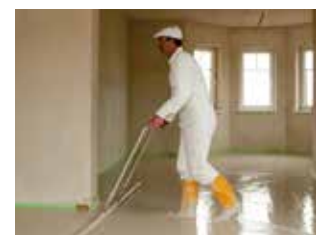
Großflächig eingebracht wird der Fließestrich durch leichtes Rakeln.
