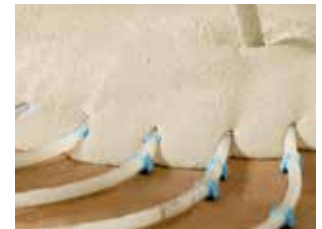
Fußbodenheizungsrohre müssen vor dem Aufschwimmen gesichert sein.
