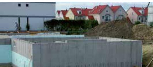
Durch die Verwendung von Stahlfaserbeton kann die herkömmliche Bewehrung bei tragenden Bauteilen ersetzt werden.
