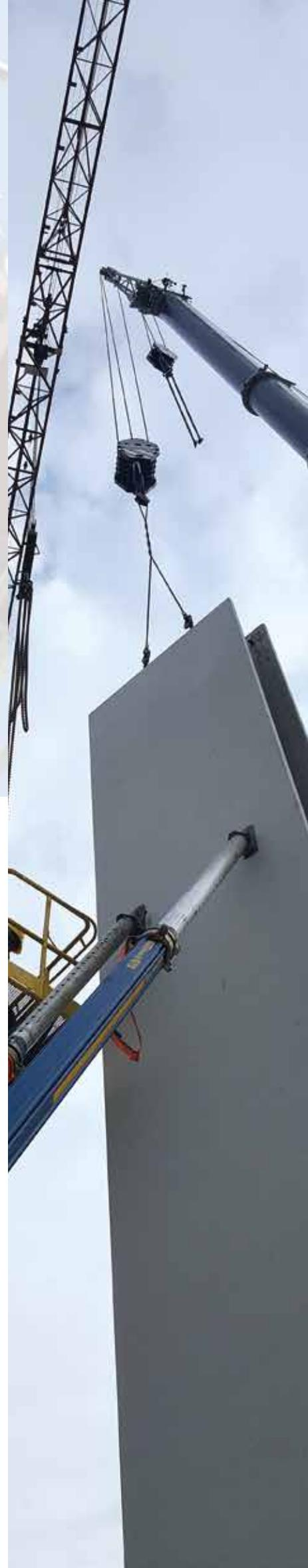
Die Verwendung von Betonfertigteilen erfüllt den Anspruch an hochqualitatives, kostengünstiges und zeitsparendes Bauen. Durch die Vorfertigung der Bauteile in modernen Anlagen erreicht man ein hohes Maß an Planungssicherheit, sowohl in technischer als auch in kostenmäßiger Hinsicht.
