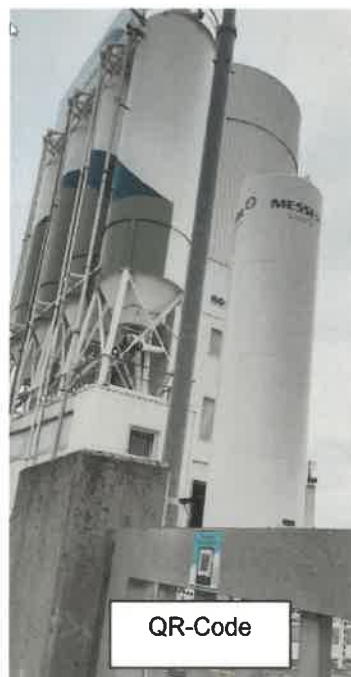
Abbildung 6: Eingangsbereich zu einem Transportbetonwerk mit QR-Code für die Meldung eines Beinaheunfalles auf der Tür
