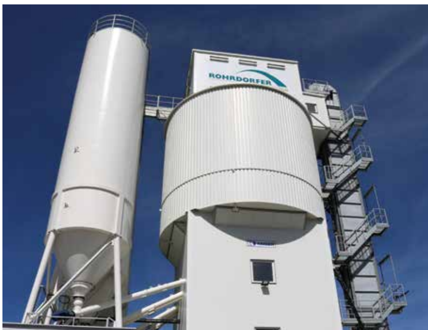
Rohrdorfer Transportbetonwerk Kapfenberg
