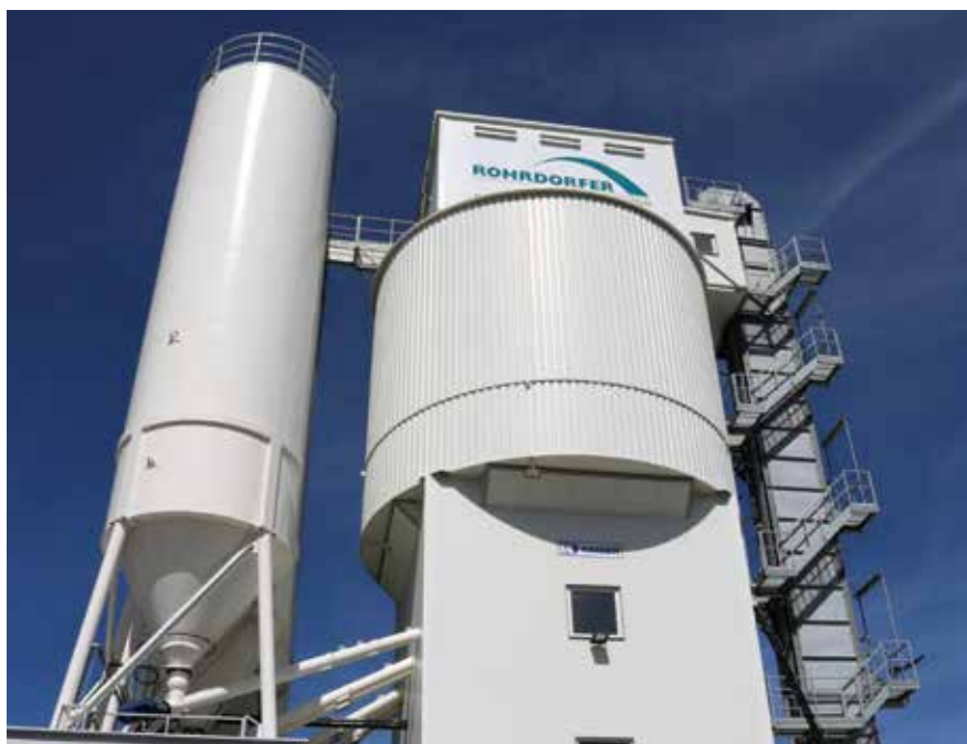
Rohrdorfer Transportbetonwerk Kapfenberg
