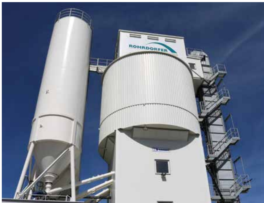
Rohrdorfer Transportbetonwerk Kapfenberg
